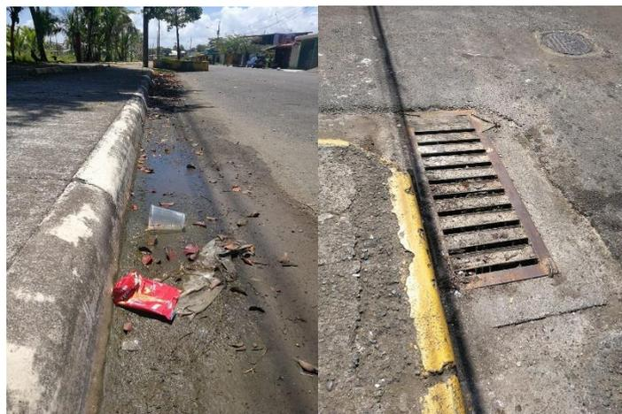
Fotografía 24: Las vías públicas y caños del alcantarillado pluvial se mantienen limpias. Además, estos cuentan con rejillas que evitan el ingreso de residuos grandes al alcantarillado. Playa Cieneguita, Limón.
